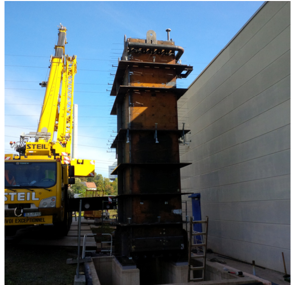
Abbildung 6: Anlieferung und Errichtung des Latentwärmespeichers
